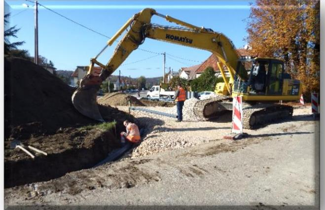
Réfection du canal de sortie de la station d'épuration et réparation des fosses de stockage.
