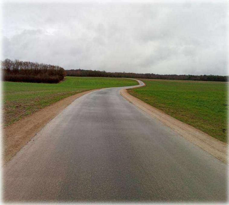
**La route d'Harréville-les-Chanteurs** a fait l'objet d'une réfection complète de la chaussée sur une distance de 3,3 kilomètres. Celle-ci se trouvait dans un état rendant indispensable sa réfection pour des raisons sécuritaires liées au trafic routier.
